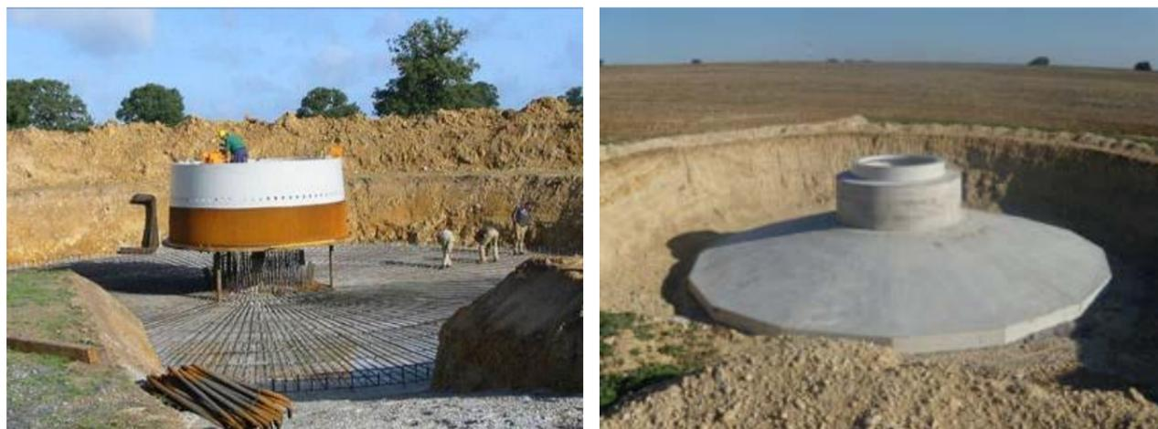
Photo 130 : Le coulage d'une fondation d'éolienne
