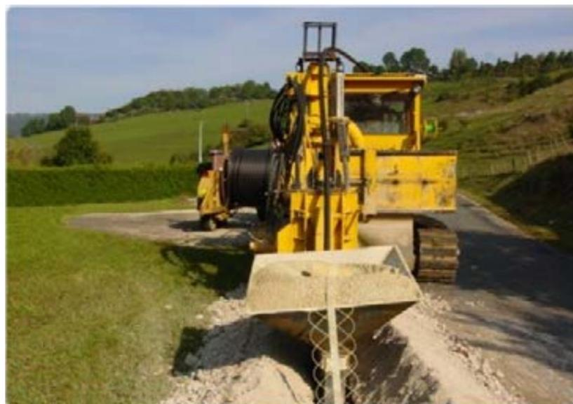
Photo 134 : La pose d'un câble souterrain depuis le poste de livraison jusqu'au réseau électrique public
